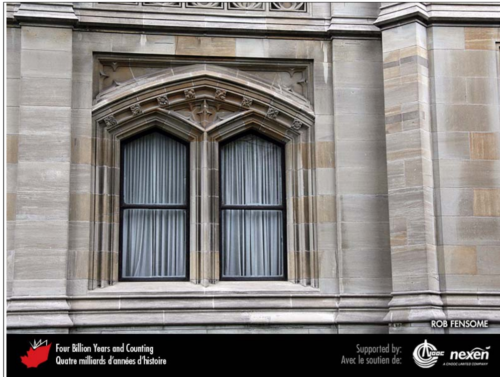
Détail du parement, en calcaire silurien de Queenston, de l'édifice Whitney Block (1925-1928), Queen's Park, Toronto, Ontario. PHOTO : ROB FENSOME.
